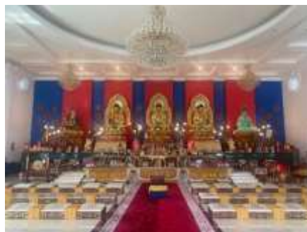
Gambar 11. Lampu Gantung dan Downlight di Area Peribadahan Lantai 3 Vihara
