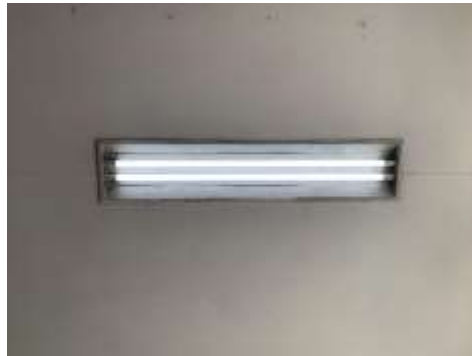
Gambar 1. Lampu tabung lurus 36 watt
