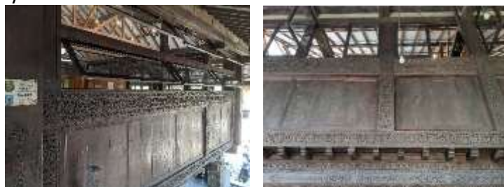
Gambar 5. Bagian Jendela Depan dan Samping Kiri yang sudah diganti
